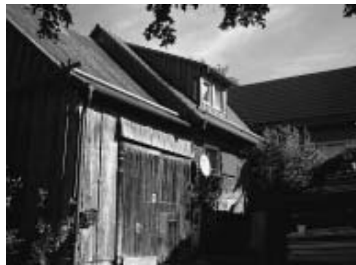
Abb. 6, oben links: Typischer Streckhof vor Sanierung / Anbau 1995
