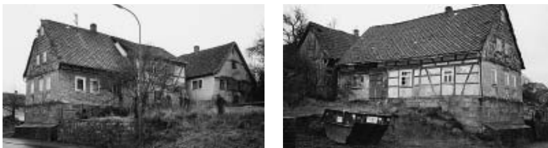
Abb. 11, 12: Eine typische Hofanlage in Sandberg im Jahr 1998: Die Gebäude stehen leer und zeigen starke Schäden. 9
